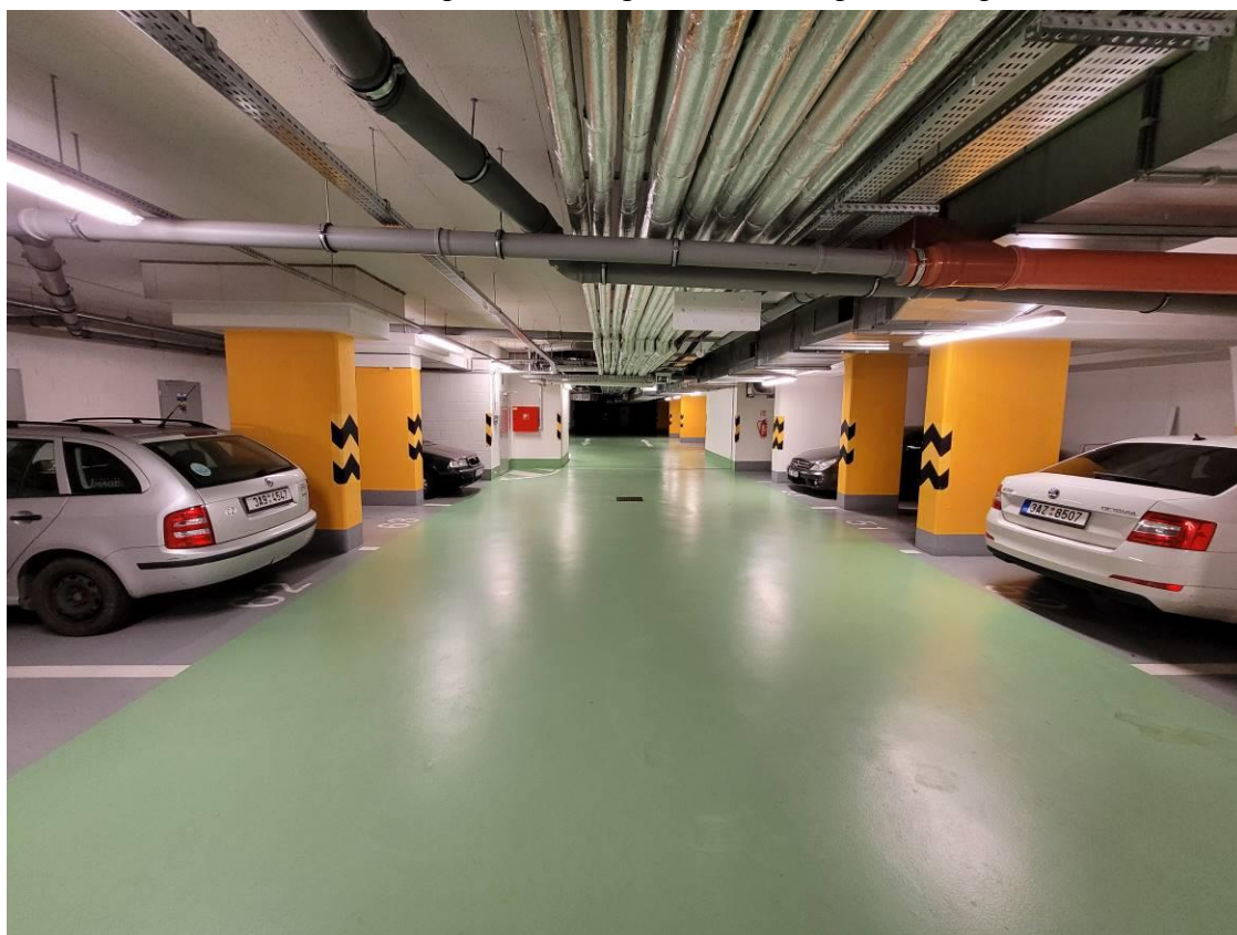
Obr. 18. Pohled do podzemního parkoviště - 1. podzemní podlaží
