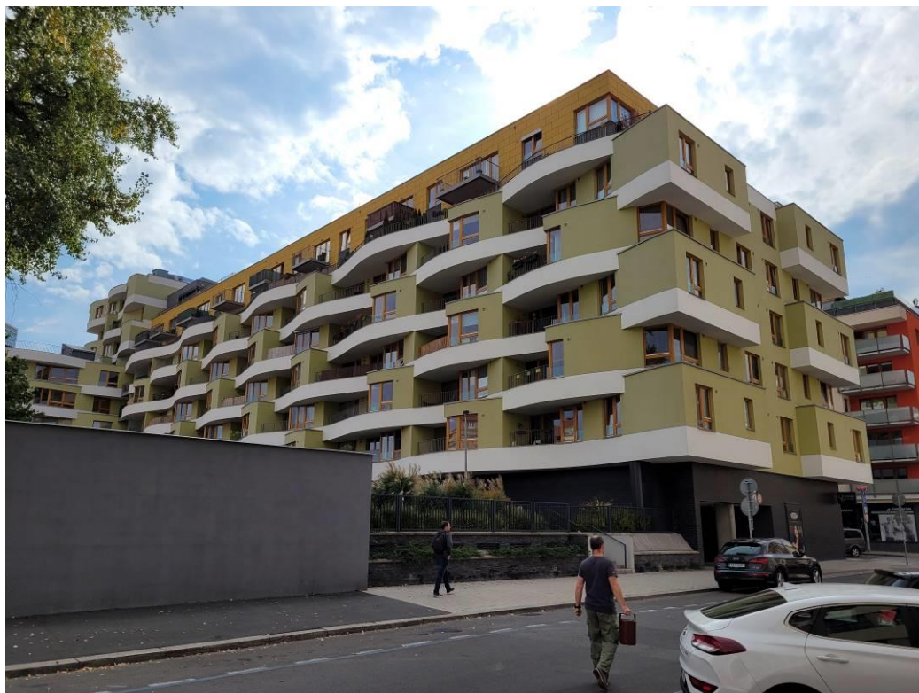
Obr. 1. Pohled na bytový dům z ulice Drahobejllova.
