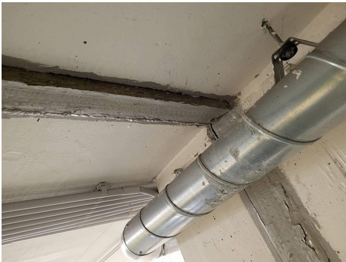
Obr. 31. Uvolněná minerální vlna z dilatační spáry (v Příloze 2 značeno jako fotografie č. 13)
